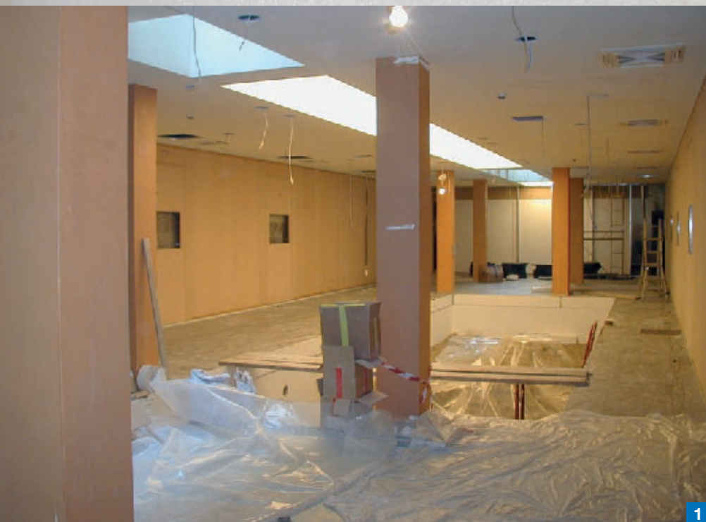
Foto 1. Pareti e colonne "nude" prima dei rivestimenti.
