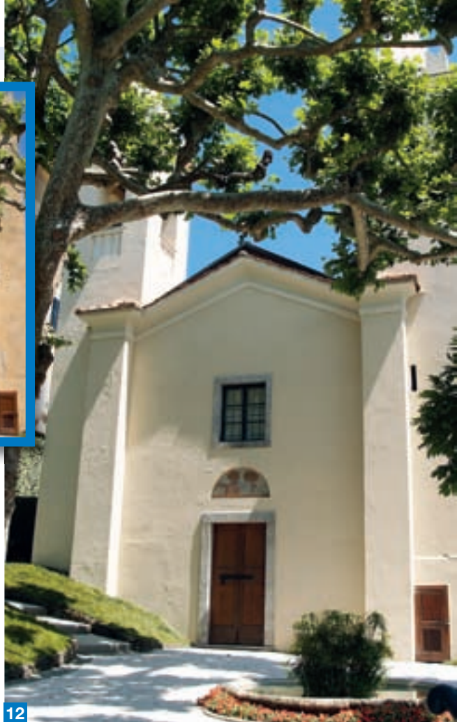
Foto 12. La merlatura delle torri e i rivestimenti della chiesa sono stati puliti e sottoposti a interventi di raschiatura parziale delle tinte. La fase finale ha visto l'applicazione di tinte ai silicati SILEXCOLOR PITTURA, previa applicazione di SILEXCOLOR PRIMER. Successiva protezione idrorepellente e incolore con ANTIPLUVIOL S. Nel riquadro, la Chiesa prima dei lavori.
