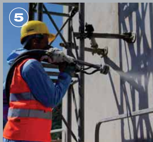
FOTO 1. Posizionamento di una nuova armatura sulla superficie idrodemolita.
