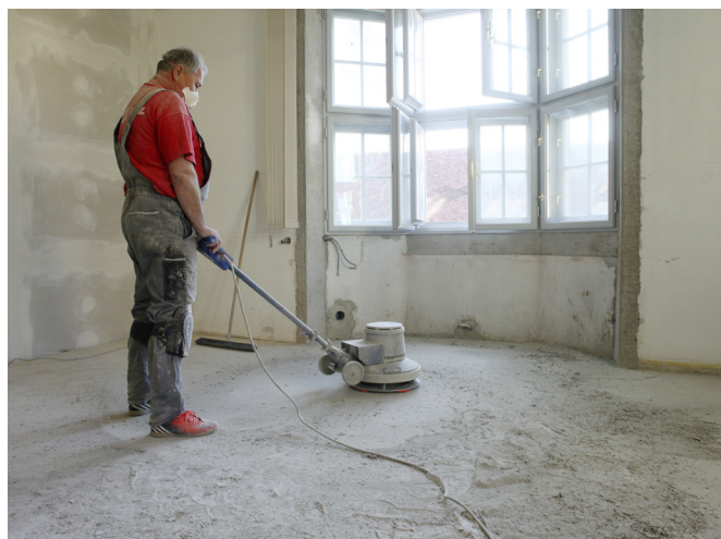
Abfräsen des alten Estriches im 4. Obgeschoß.
