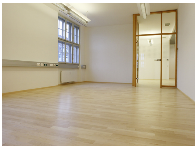
Einer der Büroräume mit fertig verlegten Parkett.
