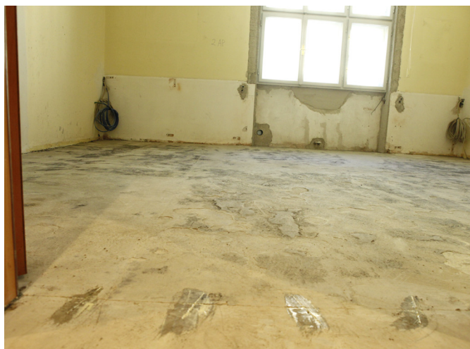
Der alte Estrich musste unbedingt überarbeitet werden.
