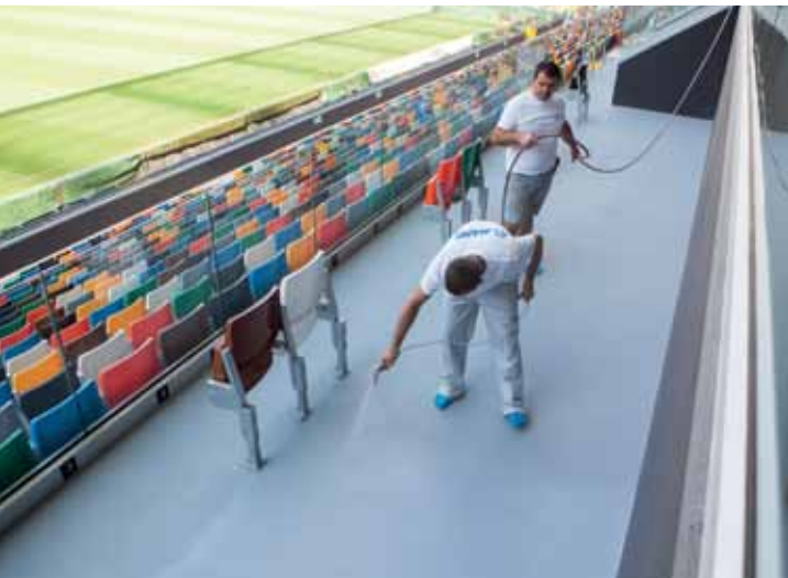
A SINISTRA. Le lavorazioni si sono concluse con una mano della finitura trasparente MAPECOAT TNS PROTECTION.
