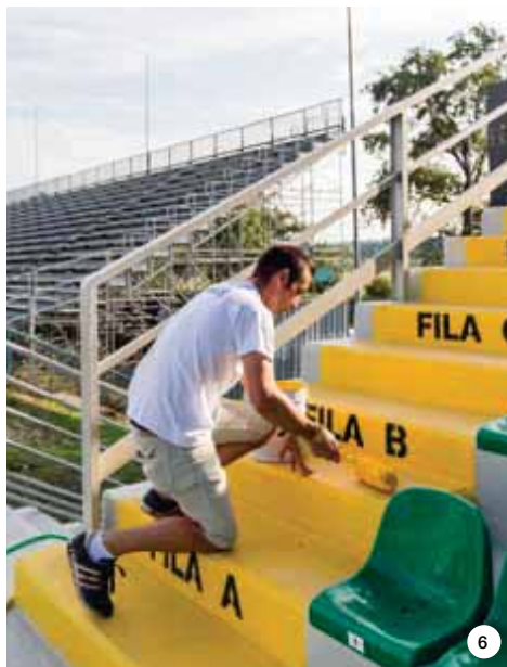
FOTO 4. Stesura di PRIMER SN. FOTO 5. Le gradinate sono state impermeabilizzate con la membrana bicomponente a base di poliurea pura PURTOP 1000. FOTO 6. Sulle tribune è stata infine applicata la finitura poliuretana MAPECOAT PU15.
