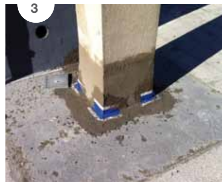
FOTO 3. Il raccordo dell'impermeabilizzazione alla base dei pilastri è stato eseguito con MAPEBAND, nastro gommato con feltro.
