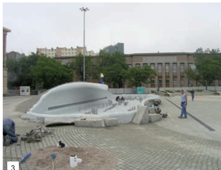
Fot. 2 i 3. Prace montażowe przy budowie fontanny o zewnętrznej powierzchni 620 m 2 i 272 dyszach.
