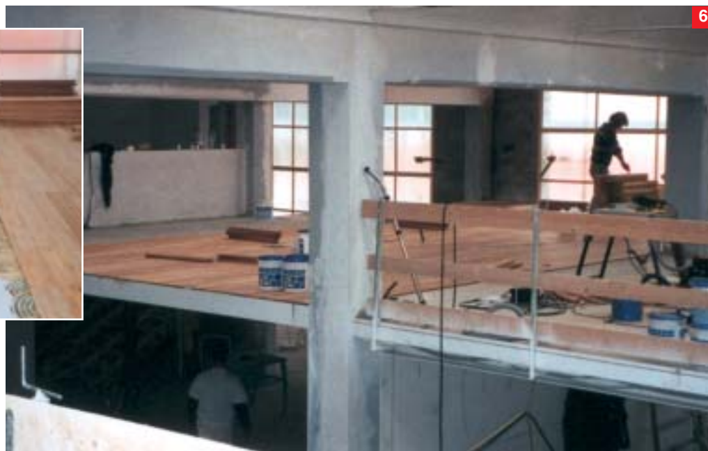
Foto 4. La zona eventi: in primo piano il pavimento in ceramica posato con l'adesivo a base cementizia Keraflex e, più lontano, il parquet incollato con l'adesivo poliuretano Lignobond.
