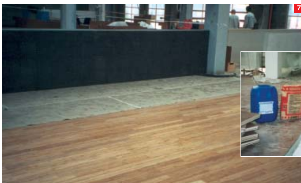
Foto 7. Per realizzare nel soppalco la successiva pavimentazione in ceramica, è stato utilizzato Mapetex System: in una prima fase sono stati stesi teli di tessuto non tessuto Mapetex, dopo di che, su di questi, sono state incollate le piastrelle in monocottura utilizzando Kerabond+Isolastic, come si nota nel particolare.
