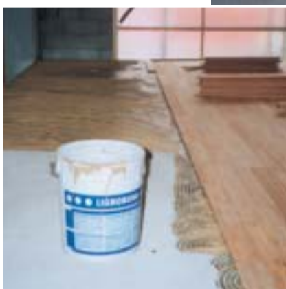
Foto 4. La zona eventi: in primo piano il pavimento in ceramica posato con l'adesivo a base cementizia Keraflex e, più lontano, il parquet incollato con l'adesivo poliuretano Lignobond.
