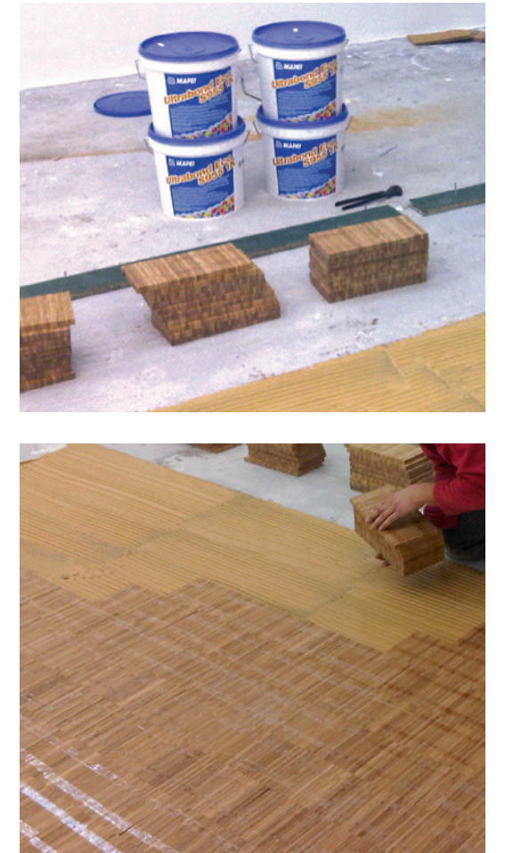
Photos ci-dessus. Le parquet en bois sur chant en chêne a été collé à l'aide d'ULTRABOND ECO S 955 1 K qui permet une excellente tenue des sillons.
