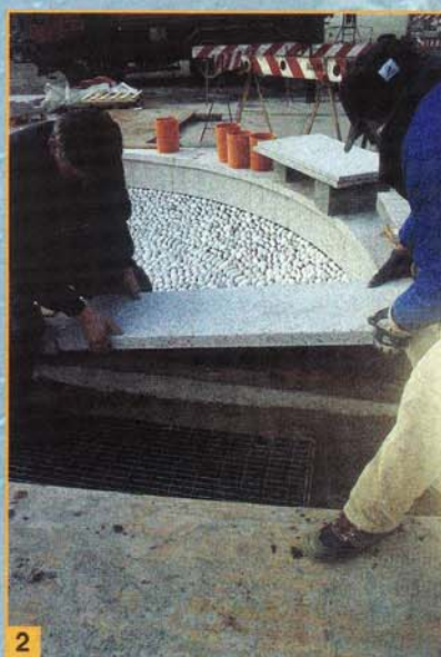
Foto 1 e 2 Stesura del GRANIRAPID* e posa delle lastre di granito Foto 3 Particolare del bordo vasca dopo la posa del rivestimento
