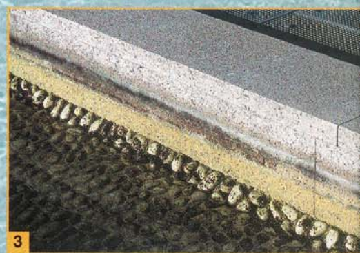
Foto 1 e 2 Stesura del GRANIRAPID* e posa delle lastre di granito Foto 3 Particolare del bordo vasca dopo la posa del rivestimento
