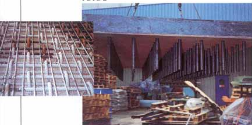
Foto 2 Particolari del cassero utilizzato per il "full scale test" per il getto degli inghisaggi con l'apparecchio d'appoggio e la parte terminale della pila riprodotta nello stabilimento Mapei di Mediglia
