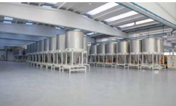
superficiale liscio o antisdrucchiolo. Ha inoltre buone resistenze chimiche, meccaniche e all'abrasione. Il rivestimento MAPEFLOOR SYSTEM 32, a una temperatura di +25 °C, risulta essere pedonabile dopo 16 ore, mentre per il transito di carrelli e muletti è utilizzabile a distanza di un giorno dalla stesura dell'ultima mano di finitura.
