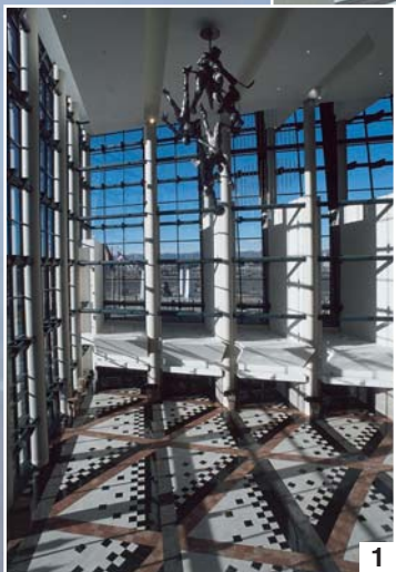
Foto 1 e 2. Per l'entrata principale e le scalinate sono state preferite le piastrelle in grado di garantire una buona resistenza all'usura di un traffico intenso. La posa è stata effettuata con ULTRA/CONTACT RS e la stuccatura delle fughe con ULTRA/COLOR.
