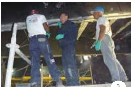
**Photo 1.** Encollage des plats carbone CARBOPLATE avec la colle époxy ADESILEX PG1
