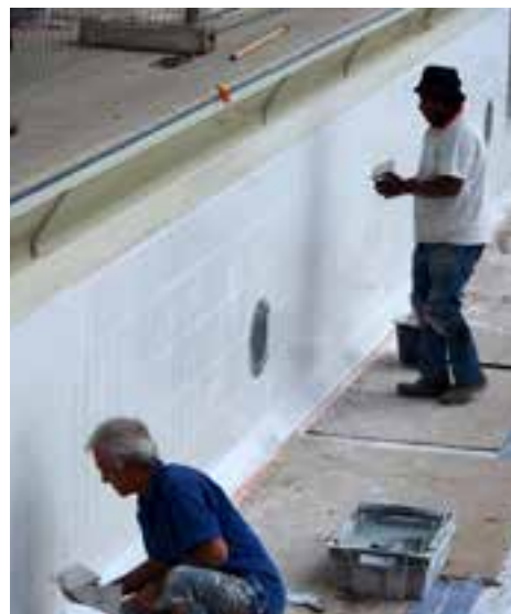
Photo ci-dessus. Le jointoiment en mur avec ULTRACOLOR PLUS
