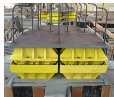
▲ Chapiteau bétonné et avec les amortisseurs en place
