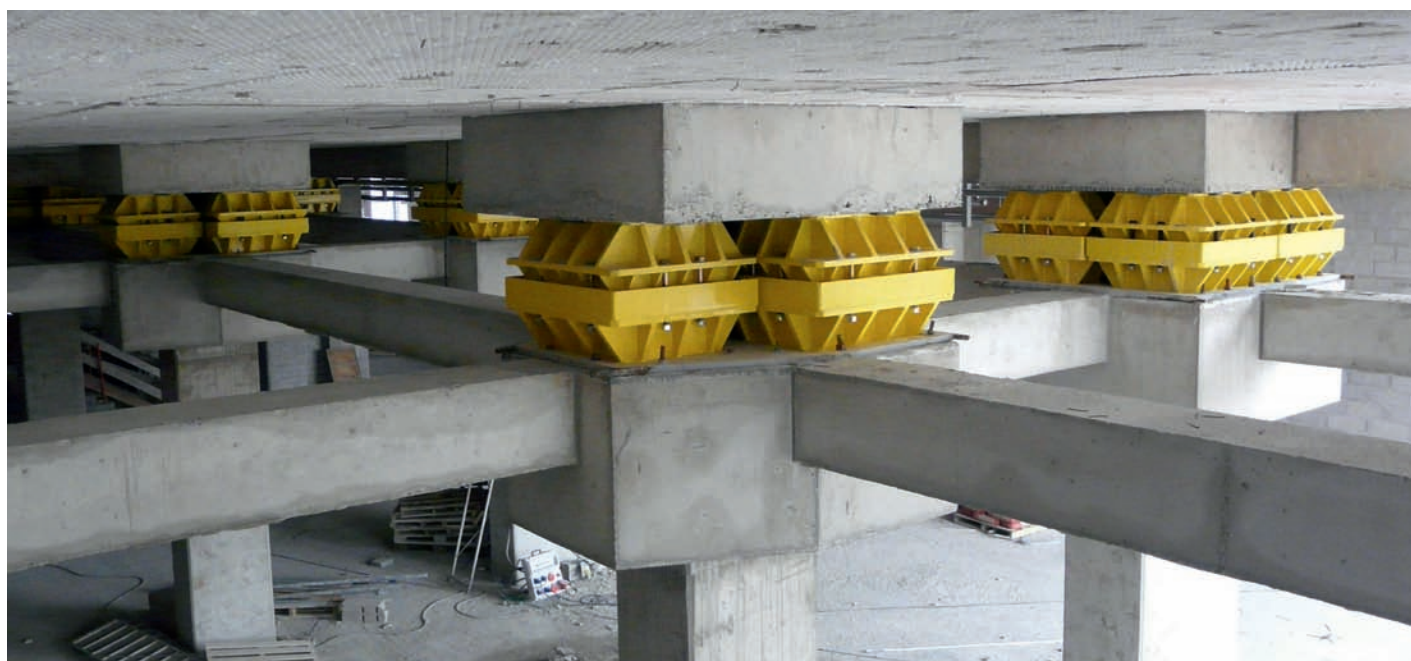
▲ Au total, 128 boîtes à ressort ont été scellées dans les sous-sols des hôtels
