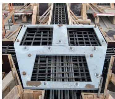
▲ Chapiteau inférieur ferrillé préparé pour le bétonnage
