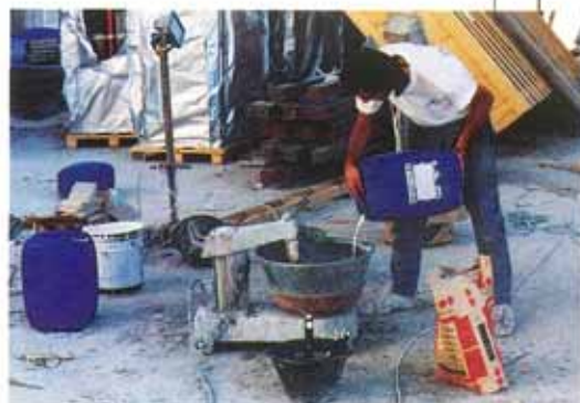
Miscelazione di Kerabond e Isolastic
