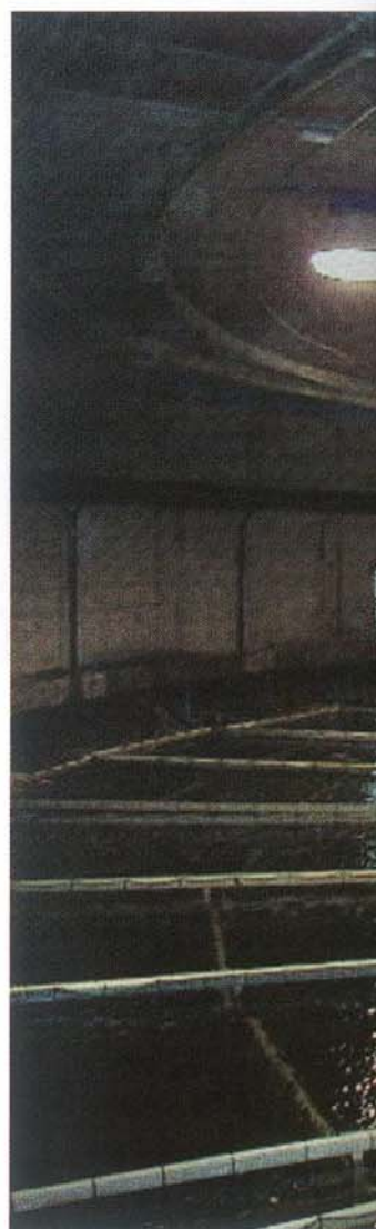
6. Cisterna degli avannotti rivestita con MAPELASTIC (prima della pulitura finale)
