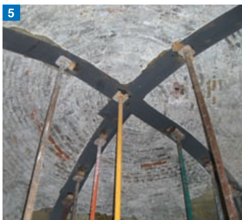
Foto 5. Un particolare della volta sorretta provvisoriamente per evitare crolli.
