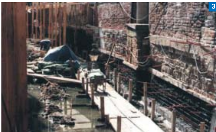
Figura 2. Scavo in presenza di acqua per la manutenzione viabile e igienica.
