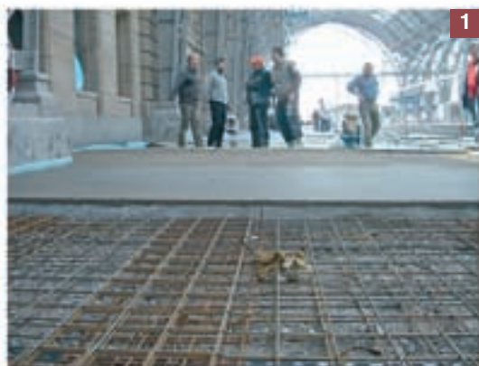
Foto 1. Preparazione del sottofondo in calcestruzzo armato con rete metallica.
