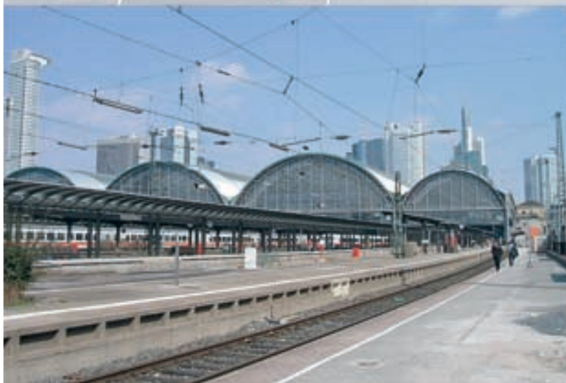
Le piattaforme di accesso ai binari prima dell'intervento di rinnovamento.
