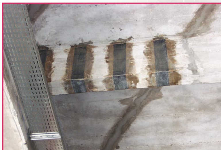
▲ Renforcement d'une poutre à l'aide des bandes de tissu Mapewrap C UNI AX
