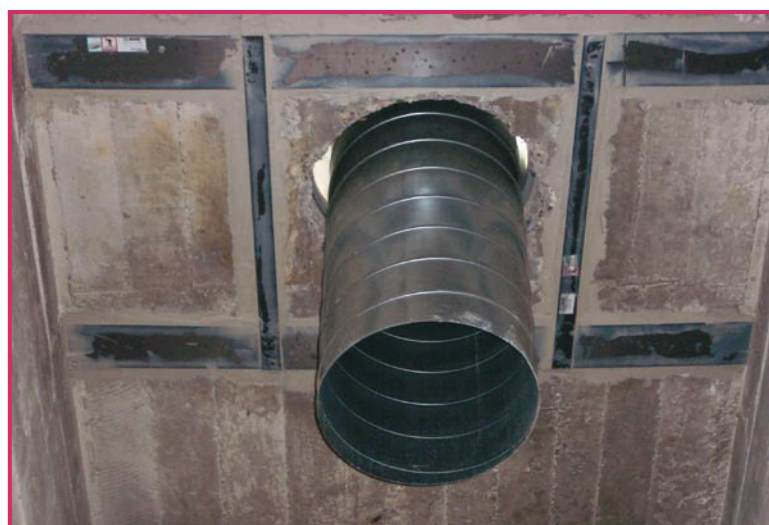
▲ Renforcement du plancher à l'aide des plats carbone Carboplate E 170 après percement d'une trémie
