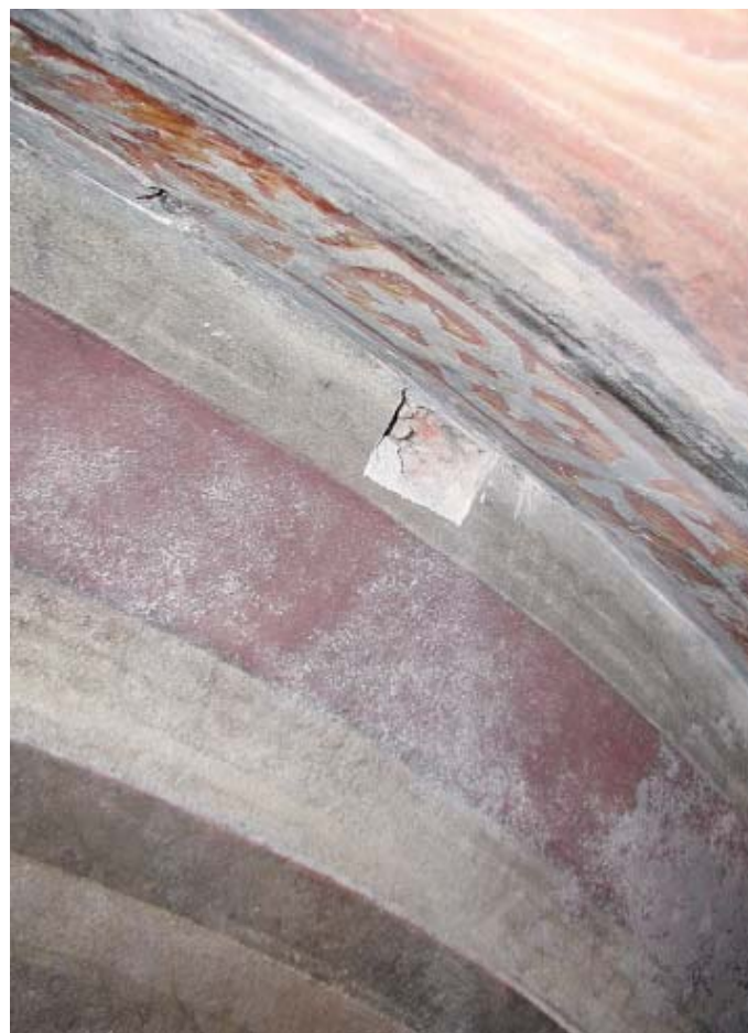
Sotto, particolare dell'indagine stratigrafica.
