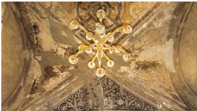
Vista d'insieme di una volta, prima dell'intervento.
