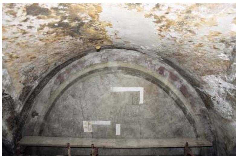
A fianco, indagini stratigrafiche condotte sulla seconda lunetta di destra.
