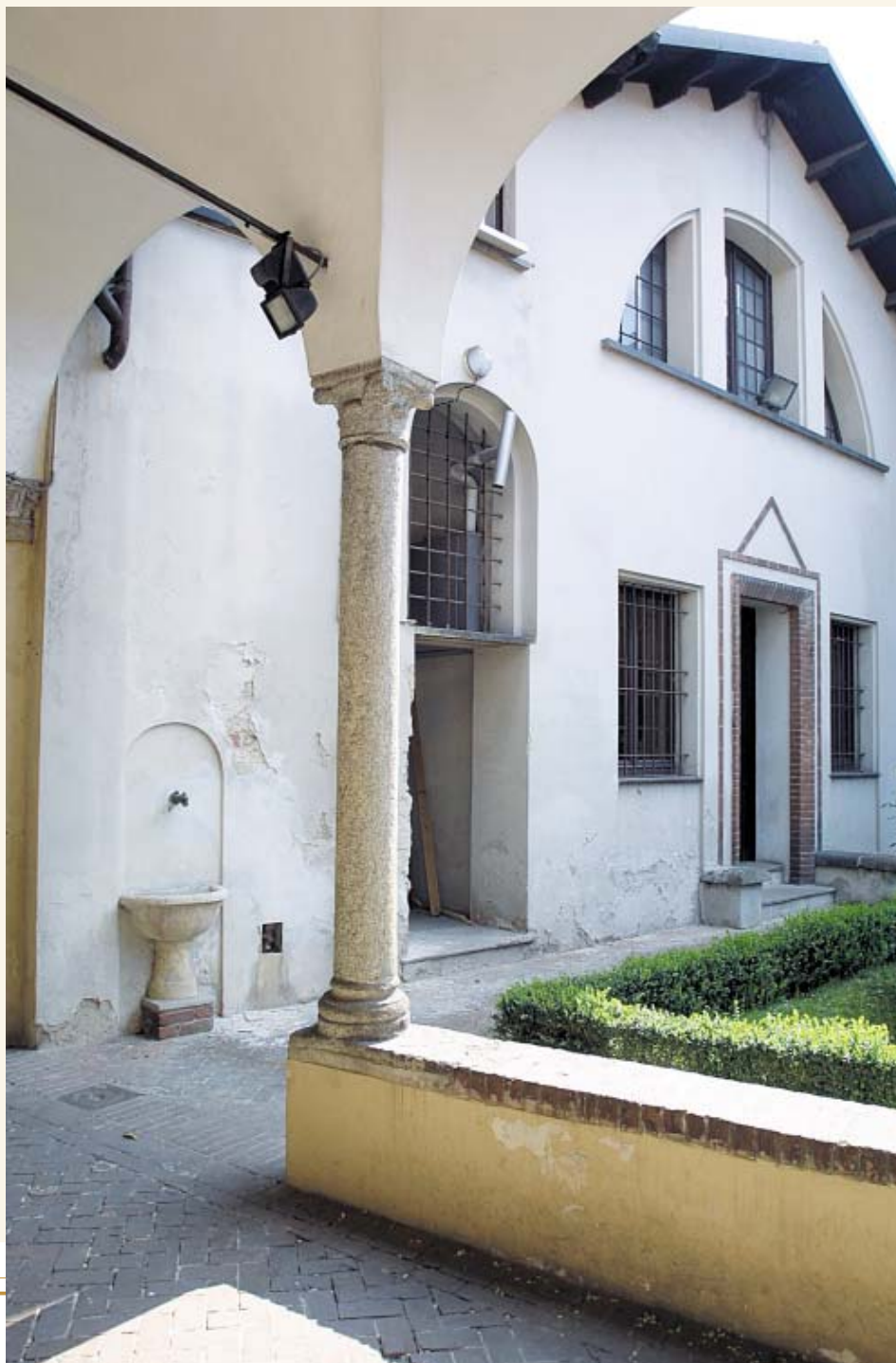
Facciata principale dell'Oratorio della Passione, prima dell'intervento.
