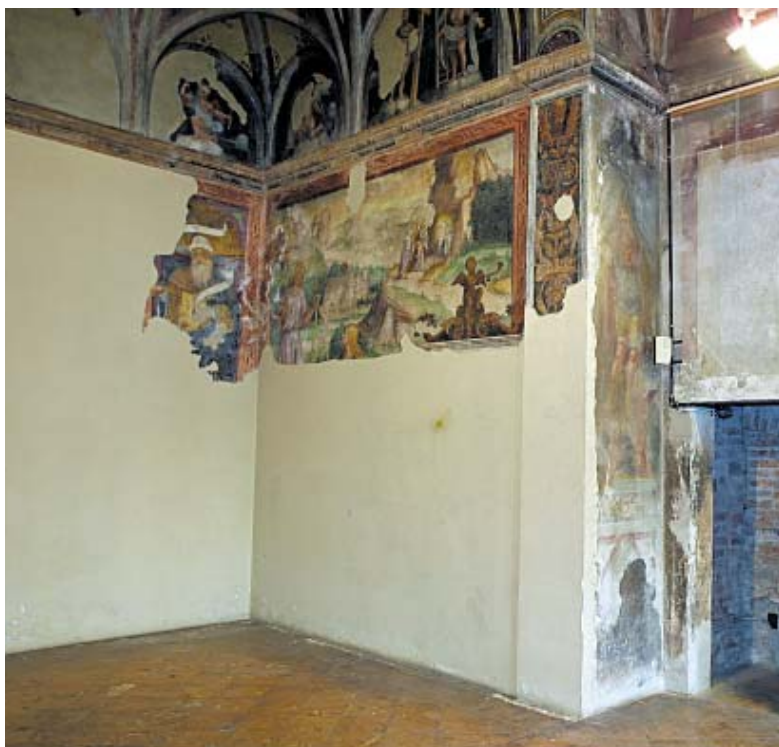
Scorcio del presbiterio prima dell'intervento.
