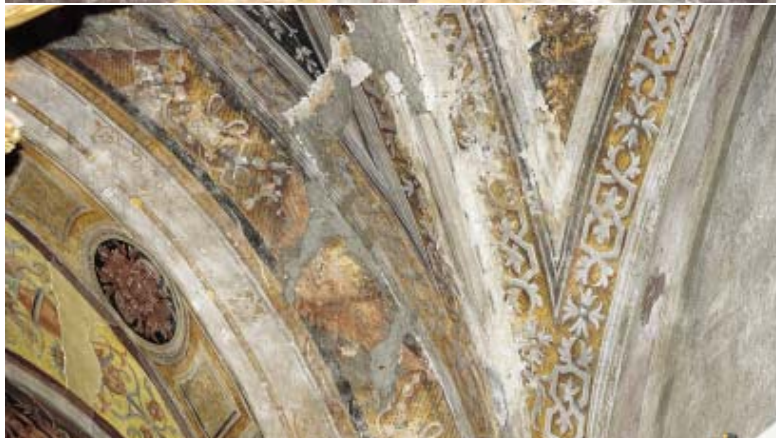
Particolare degli spigoli di partitura delle volte, prima dell'intervento.
