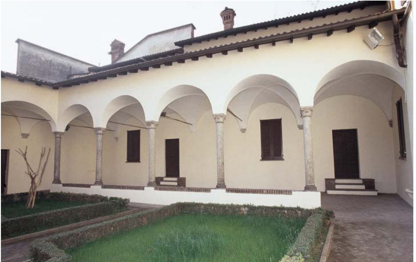
Vista d'insieme del portico ad intervento ultimato.
