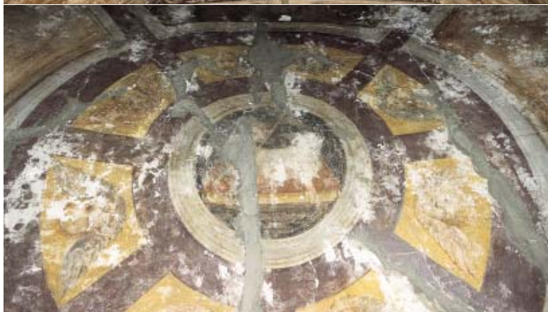
Particolari della volta e delle risarciture cementizie, prima dell'intervento.
