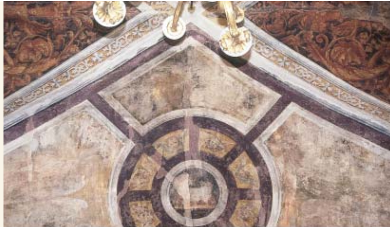
Particolari della volta dell'aula ad intervento ultimato.
