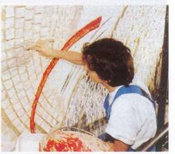
Infine, per il fissaggio dei mosaici, è stato utilizzato l'adesivo KERABOND\* additivato con il lattice elasticizzante ISOLASTIC\*, in rapporto 1:3. Questo sistema è stato impiegato per la volta e per tutte le superfici, eccetto per la parete obsoidale per cui è stata seguita un'altra procedura.
