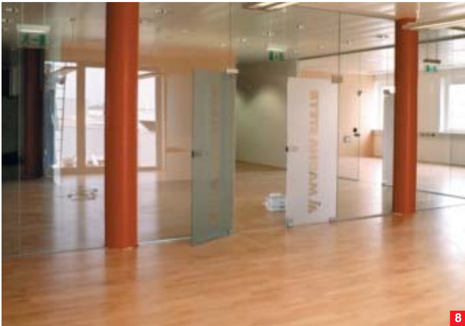
Foto 8. Scorcio del pavimento degli uffici rivestito in linoleum.
