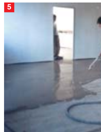
Foto 4. Livellamento dei dislivelli e delle fughe più profonde con NIVORAPID FF.
