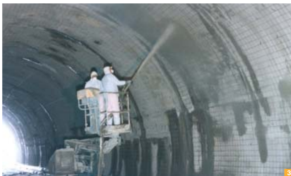
Foto 3. Tecnici in azione durante l'applicazione a spruzzo di Mapegrount Gunit. Si nota chiaramente la rete di acciaio elettrosaldata che ha formato l'armatura dell'intonaco realizzato con Mapegrount Gunit. Il prodotto è stato applicato per mezzo di una pompa a rotore alimentata direttamente con sacchi di prodotto secco, idratato all'uscita dalla lancia di proiezione.
