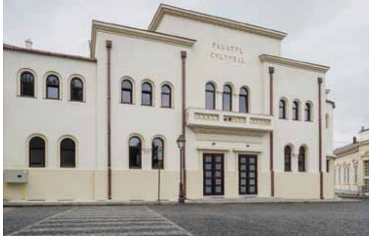
SOPRA. L'esterno del Blaj Cultural Palace a lavori ultimati.
