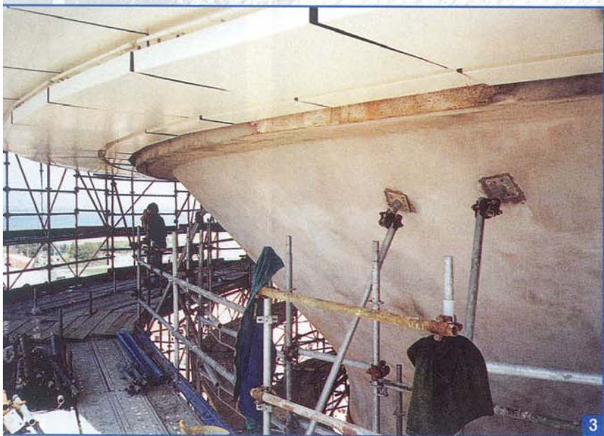
Foto 3. Messa in opera dello strato di rivestimento sulle parti degradate con NIVOPLAN F*.
