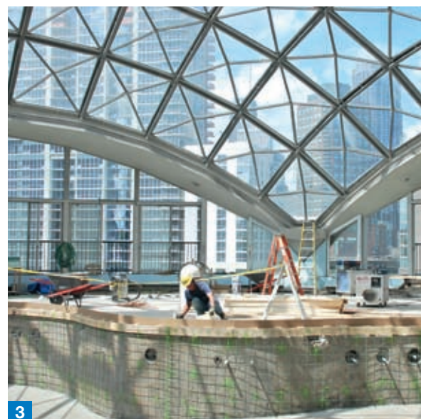
Foto 5. Le tessere in mosaico che rivestono le pareti della spa sono state posate con ADESILEX P10.
