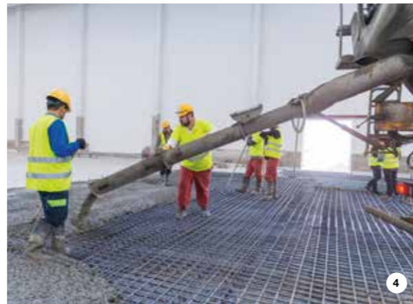
1. MAPEFER 1K, malta cementizia anticorrosiva monocomponente, è stata usata per la protezione dei ferri di armatura. 2. Per il recupero delle sezioni ammalorate dei piloni sono state usate le malte MAPEGROUT SV T e MAPEGROUT EASY FLOW. 3. Dopo il ripristino del calcestruzzo, si è proceduto alla finitura e protezione delle superfici con ELASTOCOLOR PITTURA. 4. Il nuovo pavimento in calcestruzzo è stato realizzato con MAPECRETE SYSTEM.
