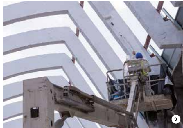
1. MAPEFER 1K, malta cementizia anticorrosiva monocomponente, è stata usata per la protezione dei ferri di armatura. 2. Per il recupero delle sezioni ammalorate dei piloni sono state usate le malte MAPEGROUT SV T e MAPEGROUT EASY FLOW. 3. Dopo il ripristino del calcestruzzo, si è proceduto alla finitura e protezione delle superfici con ELASTOCOLOR PITTURA. 4. Il nuovo pavimento in calcestruzzo è stato realizzato con MAPECRETE SYSTEM.
