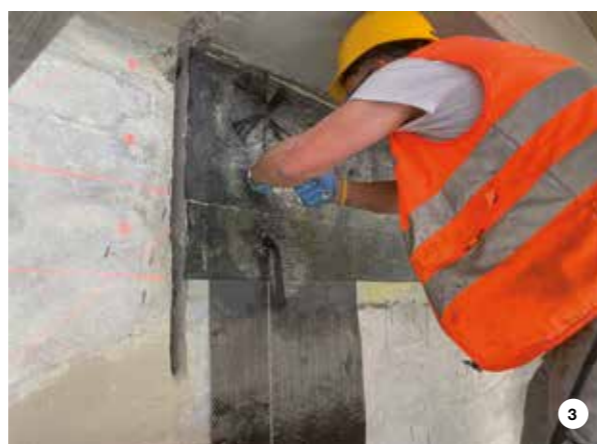
1. La passivazione dei ferri di armatura è stata effettuata con MAPEFER 1K. 2 e 3. Per il rinforzo strutturale è stato scelto MAPEWRAP C UNI-AX SYSTEM, sistema composto da tessuti unidirezionale in fibra di carbonio ad alta resistenza.
