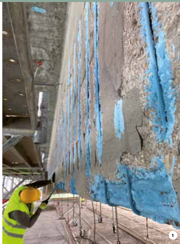
1. La passivazione dei ferri di armatura è stata effettuata con MAPEFER 1K. 2 e 3. Per il rinforzo strutturale è stato scelto MAPEWRAP C UNI-AX SYSTEM, sistema composto da tessuti unidirezionale in fibra di carbonio ad alta resistenza.
