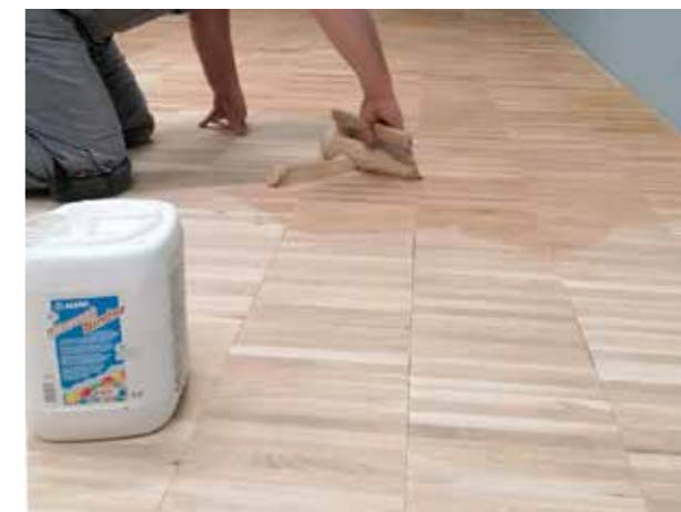
La grande sala polifunzionale al piano terra ha un pavimento in parquet posato con ULTRABOND P990 1K e verniciato con ULTRACOAT HT 2K.
