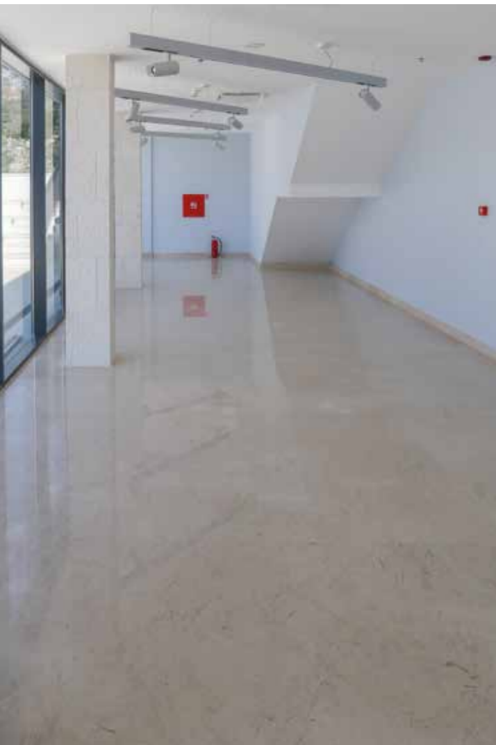
I pavimenti in resina del primo sono stati realizzati con il sistema epossidico MAPEFLOOR SYSTEM 33.
