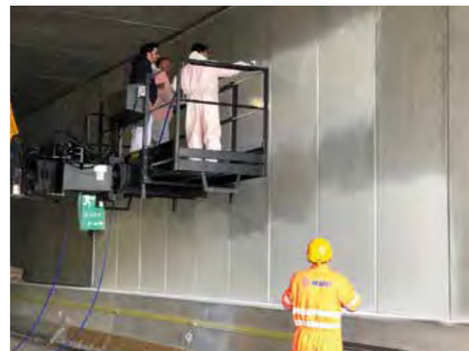
IN ALTO. Un'immagine del getto del calcestruzzo proiettato all'interno delle gallerie. A SINISTRA. L'impermeabilizzazione coi teli MAPEPLAN TU S 20. A DESTRA. La verniciatura delle pareti è stata effettuata con la pittura epossidica bicomponente MAPECOAT W HRI.
