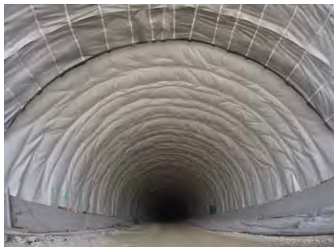
IN ALTO. Un'immagine del getto del calcestruzzo proiettato all'interno delle gallerie. A SINISTRA. L'impermeabilizzazione coi teli MAPEPLAN TU S 20. A DESTRA. La verniciatura delle pareti è stata effettuata con la pittura epossidica bicomponente MAPECOAT W HRI.
