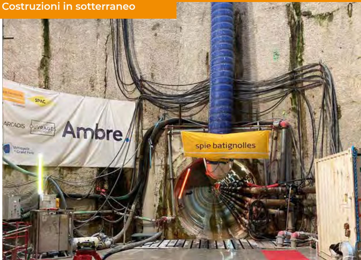
IN ALTO. L'ingresso del tunnel realizzato per interrare i cavi elettrici.
