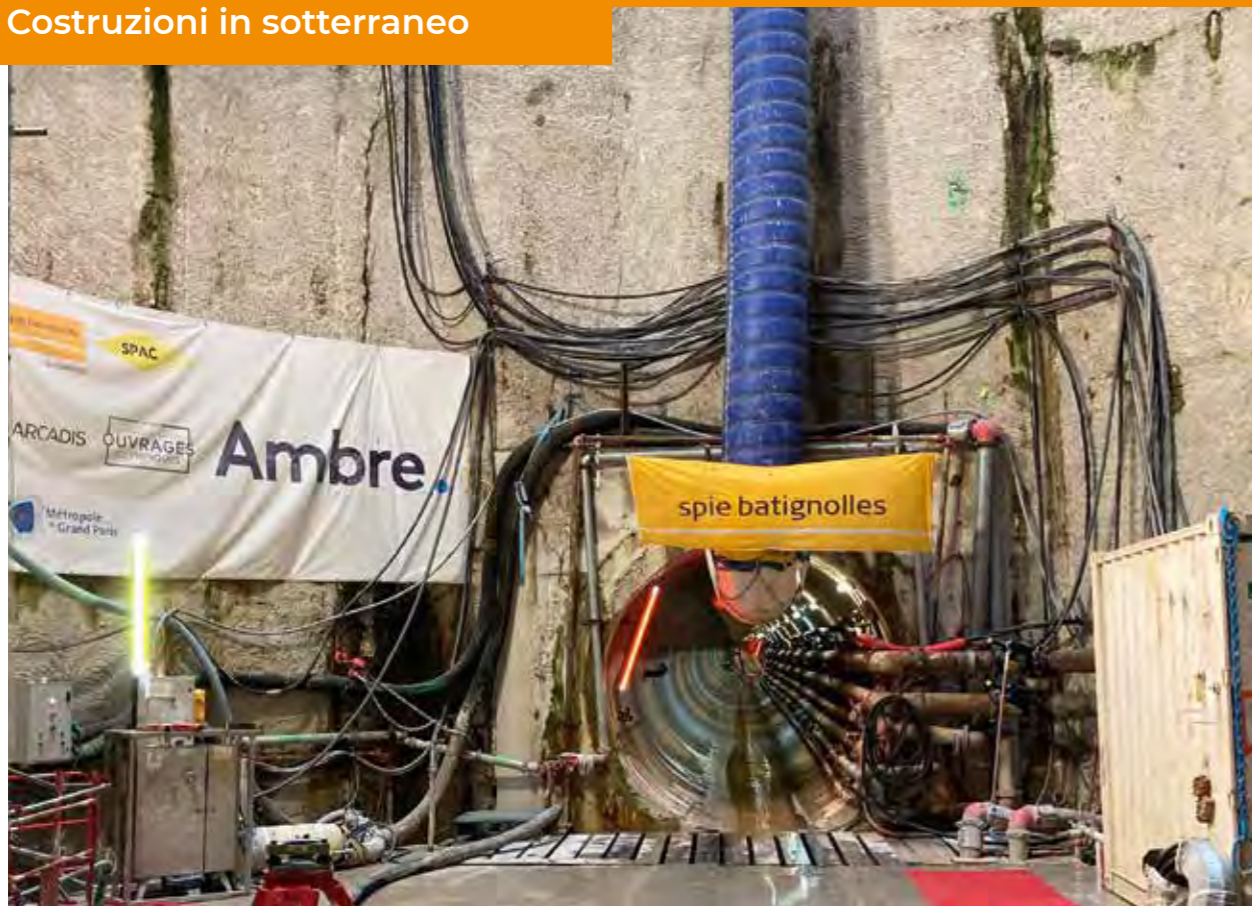
IN ALTO. L'ingresso del tunnel realizzato per interrare i cavi elettrici.
