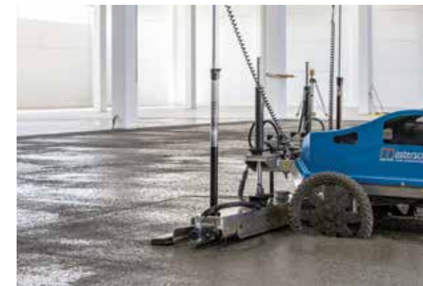
Due fasi esecutive della pavimentazione. A sinistra, lo scarico del calcestruzzo a canale. A destra, la stesa del calcestruzzo con laser screed.
