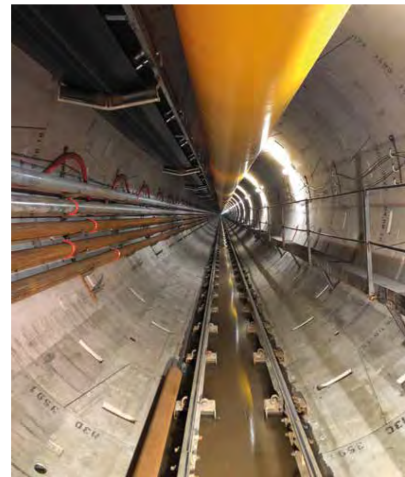
Vista interna della galleria scavata e rivestita con conci.
