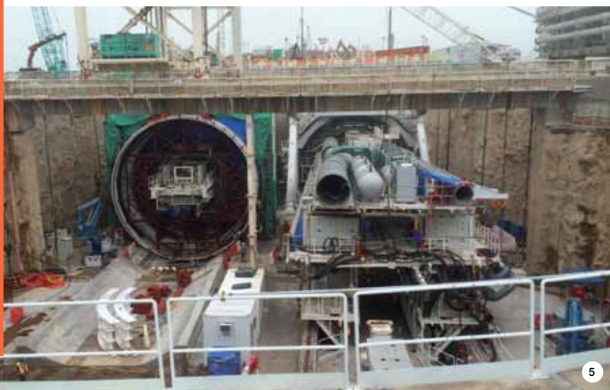
FOTO 5. La grande TBM in azione per realizzare il tunnel sottomarino.
