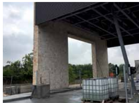
Posa del rivestimento in pietra sui caselli autostradali
