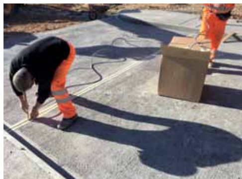
Siliconatura delle piste dei caselli autostradali
