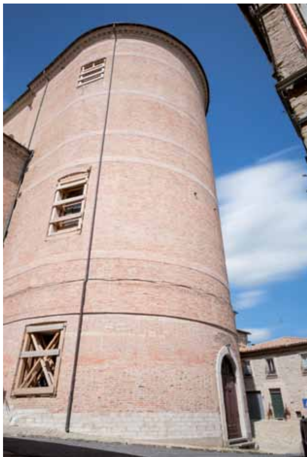
A SINISTRA. La cattedrale di Camerino durante i lavori di ripristino. IN ALTO. Un'immagine dell'abside.
