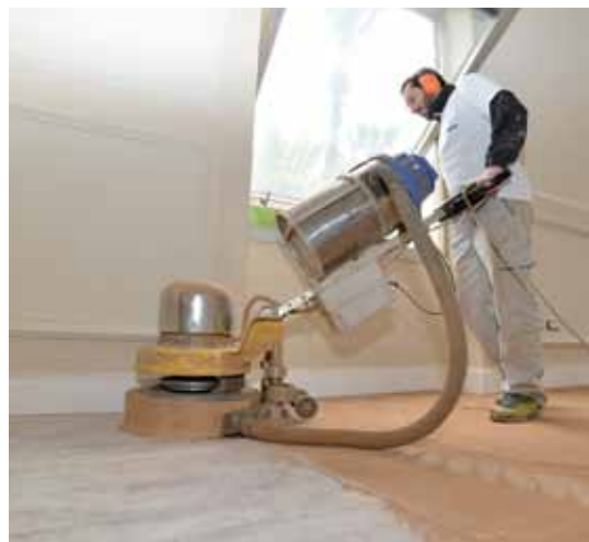
Per la stuccatura del parquet è stato usato ULTRACOAT BINDER, legante all'acqua da miscelare con farina di legno (nella foto in alto la carteggiatura), mentre la lucidatura finale è stata effettuata con la vernice all'acqua ULTRACOAT HIGH TRAFFIC (in basso).
