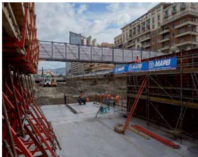
NELLA PAGINA ACCANTO. Lavori di scavo e ricostruzione finalizzati all'ampliamento della sezione. SOPRA. Vista d'insieme dello snodo tra Corso Italia e Viale Brigate Bisagno, zona in cui è stato effettuato l'intervento. SOTTO. Fasi di preparazione per il getto delle nuove strutture in calcestruzzo armato.
