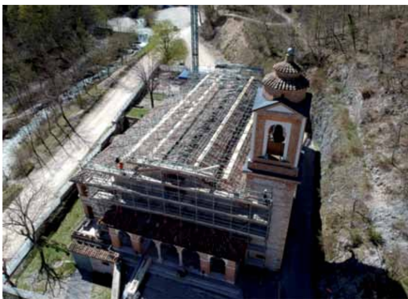
A SINISTRA. Il Santuario della Madonna dell'Ambro a intervento ultimato. A DESTRA. Il Santuario puntellato in seguito al terremoto del 2016.
