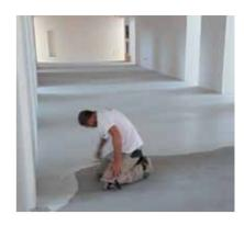
STE con l'aggiunta della miscela di aggregati DYNASTONE TZ (spessore 8 mm). L'intervento è terminato con una mano di MAPELUX LUCIDA, cera metallizzata a doppia reticolazione e alta resistenza al traffico molto intenso, con effetto lucido. *Pianoterra, primo e secondo piano.* Per gli uffici al pianoterra
