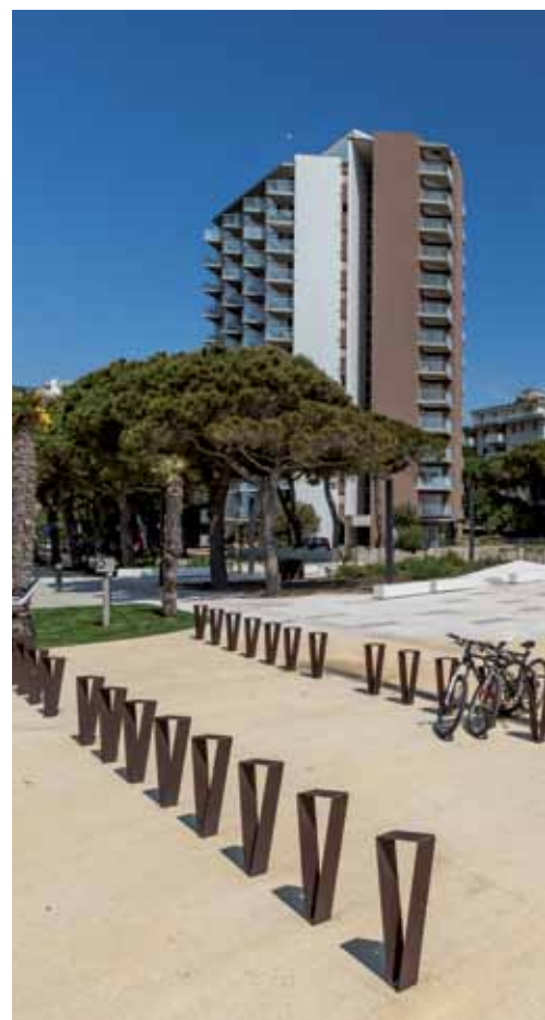
FOTO 5. Particolare della pavimentazione in calcestruzzo effetto lavato appositamente formulato per riprodurre l'aspetto della sabbia della spiaggia.
