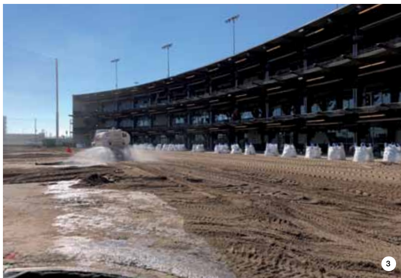
Preparazione dell'area oggetto del trattamento con MAPESOIL 100.
