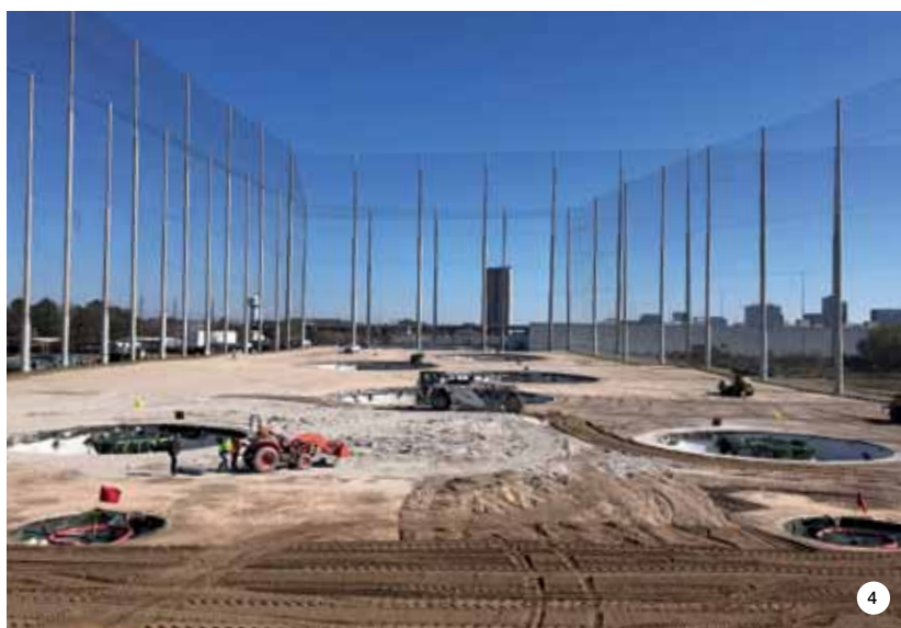
Stabilizzazione con MAPESOIL 100 del campo pratica (si noti l'altezza delle recinzioni perimetrali).
