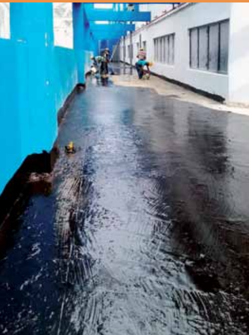
A SINISTRA. I pavimenti dei corridoi e dei palchi sono stati trattati con la membrana impermeabilizzante PLASTIMUL PU.
