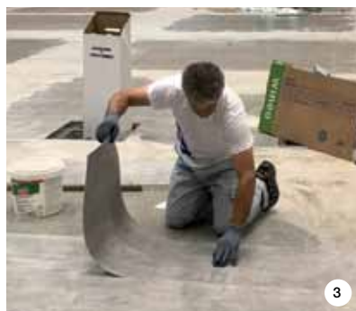
1. Prima della posa della pavimentazione, la rasatura è stata effettuata con PLANIPREP FAST TRACK. Dove necessario, sono stati utilizzati anche NIVORAPID e LATEX PLUS. 2, 3 e 4. Il biopavimento Purline della Wimeo è stato posato con ADESILEX G 20. 5. L'adesivo di montaggio ULTRABOND MS RAPID è stato scelto, insieme al sigillante MAPESIL AC, per sigillare i pozzetti.
