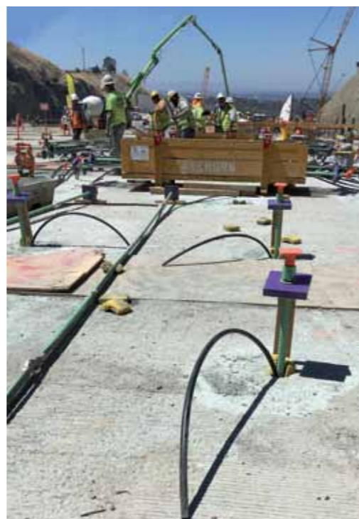
SOPRA. La malta PLANIGROUT 755 è stata pompata direttamente nei fori che ospitano le barre di armatura.
